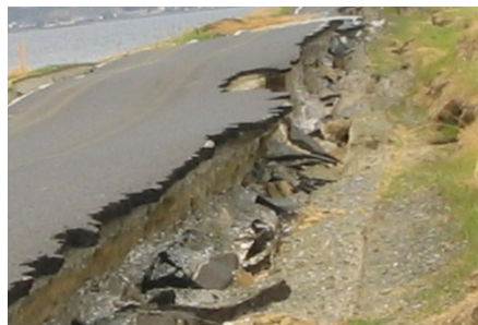
稲敷市本新地先 (霞ヶ浦の堤防)
