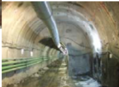
地すべりの動きを止めるための深礎杭工、排水トンネルの設置
