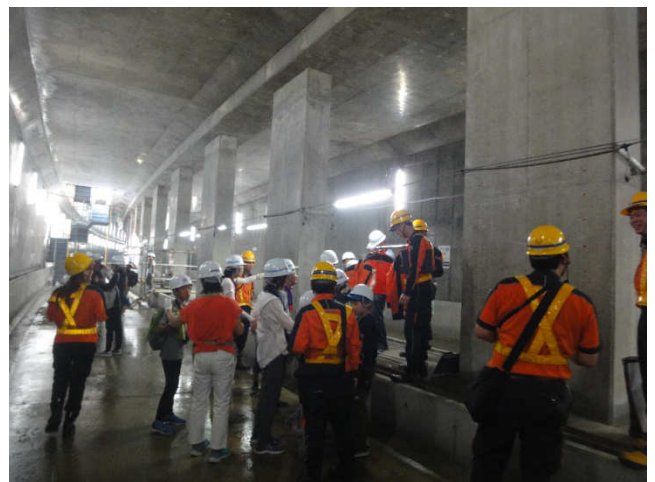
写真-2 北2工区トンネル内部
