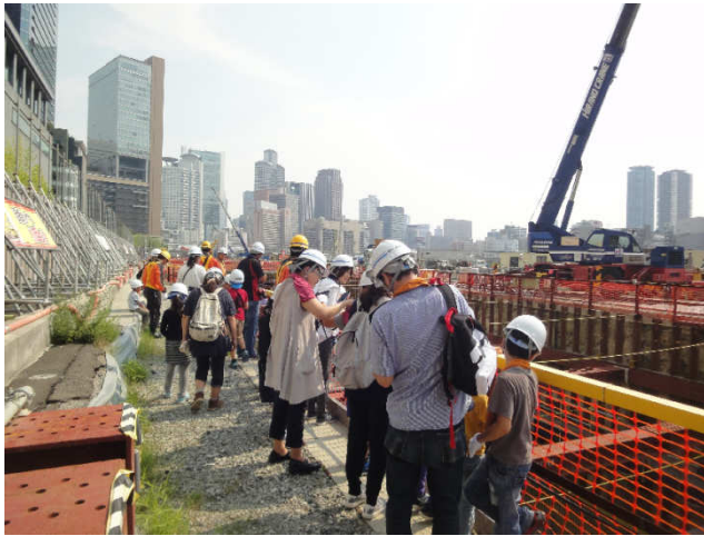
写真-3 北3工区トンネル上部
