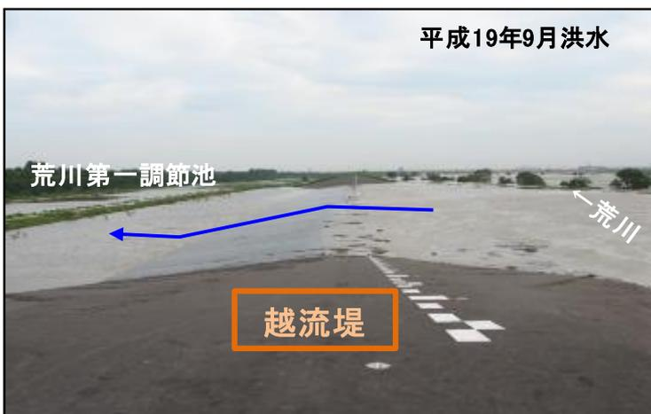
洪水時には荒川から越流堤を経て調節池へ流入
