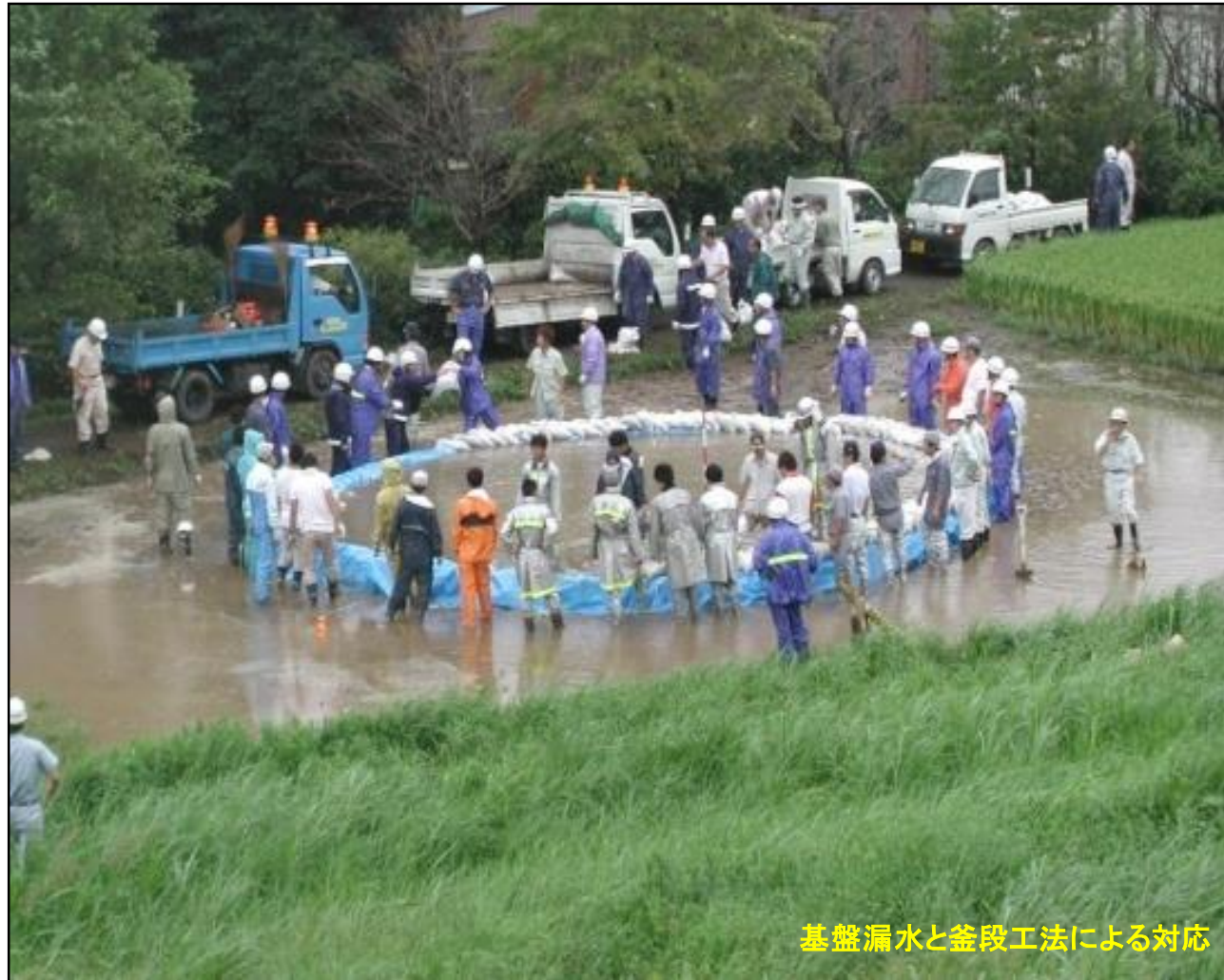
堤体漏水・基盤漏水発生箇所
