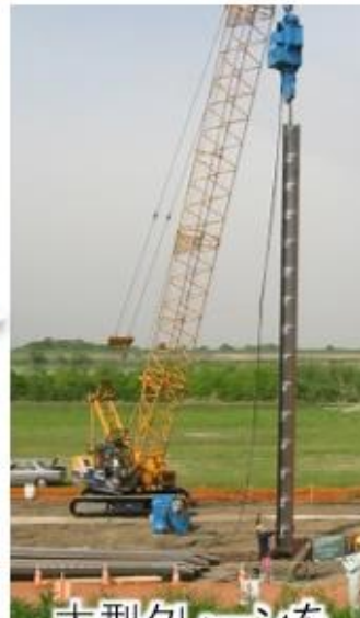
大型クレーンを使い矢板を設置
