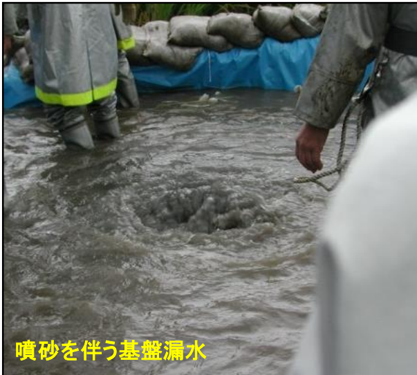
堤体漏水・基盤漏水発生箇所
