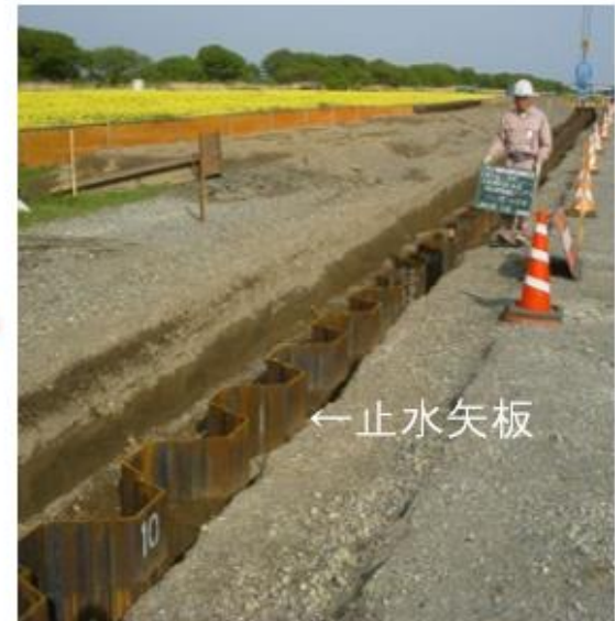
止水矢板設置完了
