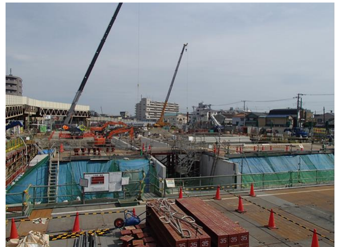
写真-2 新宿線交差部 工事状況
