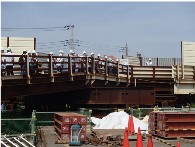
写真-1 工所用仮設棧橋より新宿線交差部の見学
