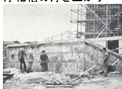
県営アパートの倒壊 側方変位
