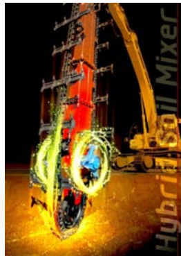
ハイブリッドソイルミキサー工法
