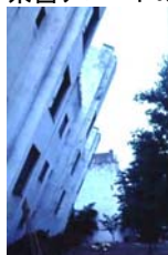
県営アパートの倒壊 側方変位
