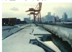
岸壁の水平変位
