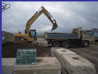
処理土積込・運搬状況
