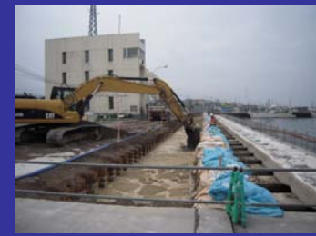
処理土投入状況
