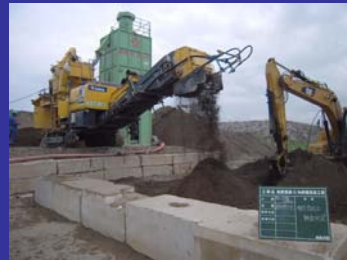
処理土製造状況
