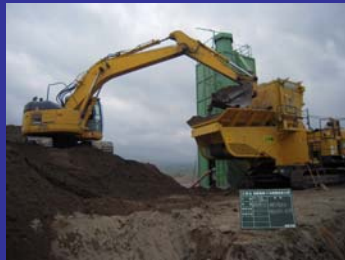
土砂プラント投入状況
