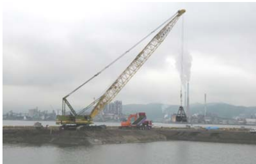
写真-2 改良土の投入 (クラムシェルバケット G.L.-10.5m~-3.2m)
