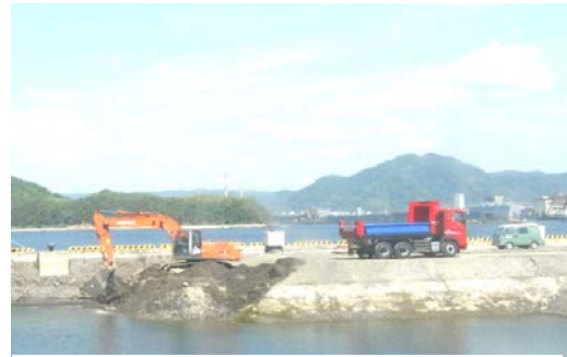
写真-3 改良土の投入 (バックホウ G.L.-3.2m~+3.35m)
