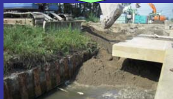
事前混合処理土投入状況
