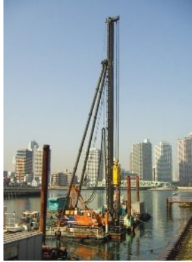
CDM-FLOAT工法施工状況
