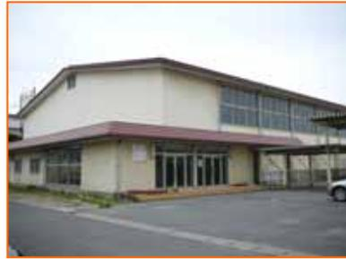
校舎3/26段差40cm:鋼管杭74m(TAIP) 体育館7/18段差なし:地盤改良? + 節杭8m
