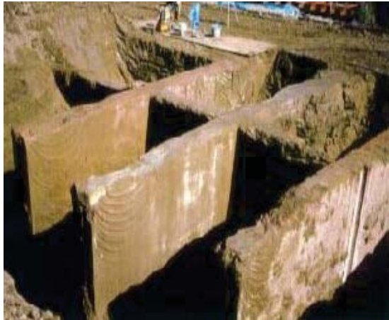
改良壁の掘り出し状況
