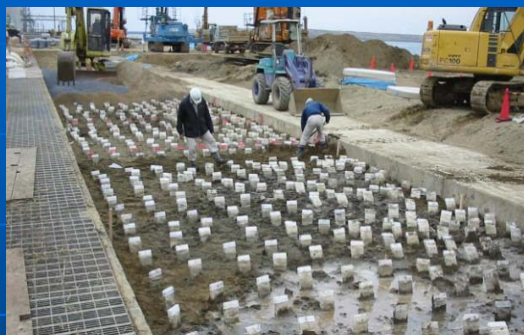
グリッドドレーン施工状況
