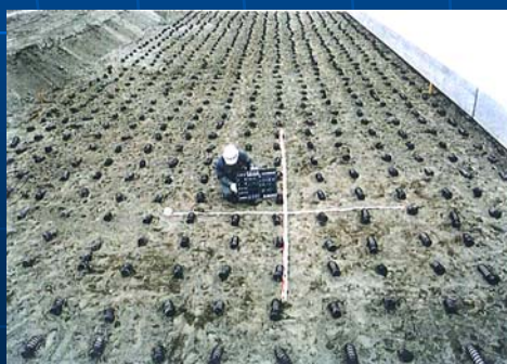
スパイラルドレーン施工状況(b)
