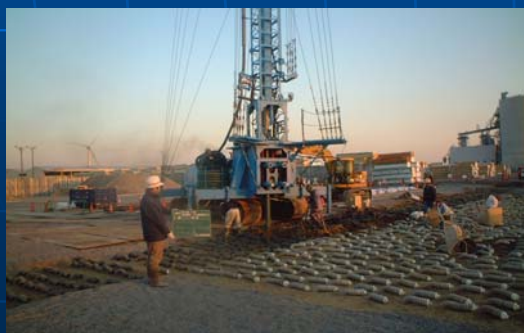
スパイラルドレーン施工状況
