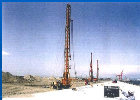
スパイラルドレーン施工状況(a)
