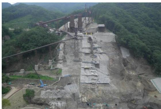
写真-1 堤体左岸掘削状況
