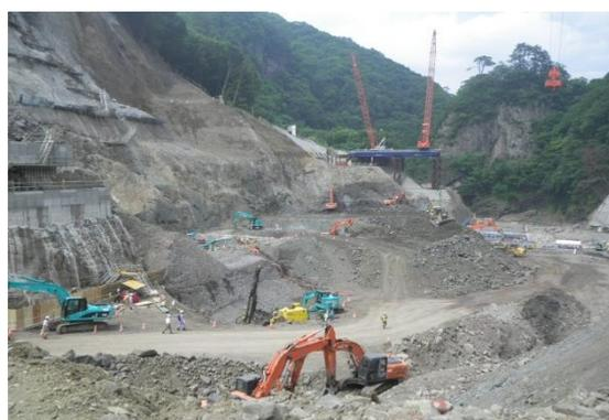
写真-2 堤体河床部掘削状況
