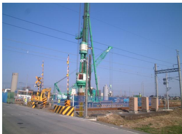
写真 1 東武跨線橋での鋼管杭施工状況
