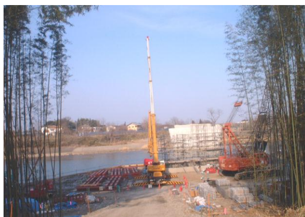
写真 2 利根川新橋（仮称）P4 橋脚でのケーソン工事状況
