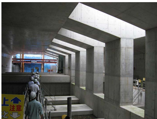
写真 スリット構造半地下躯体
