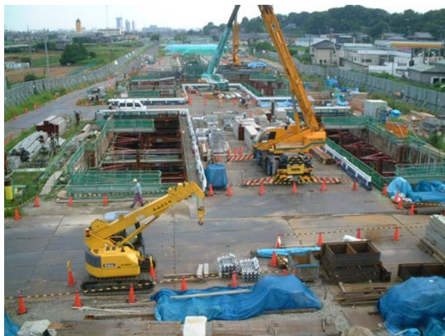
写真 国分掘割試験施工区間 全景
