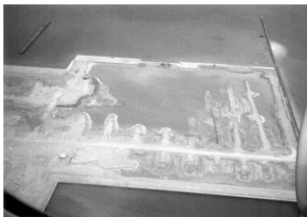
写真-4.1 建設中の埋立地の空中写真
