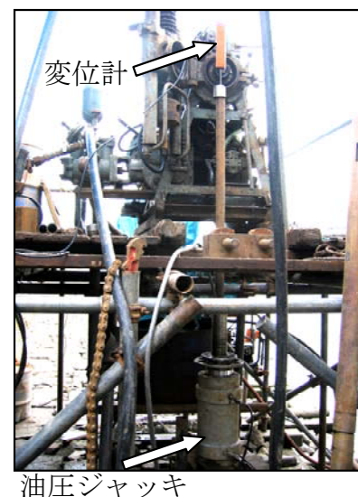
写真-5.2 測定状況
