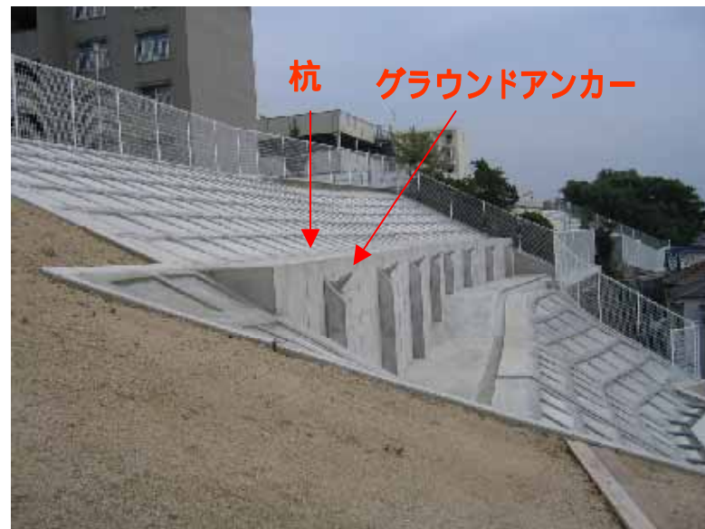
杭とグラウンドアンカーによる抑止工
