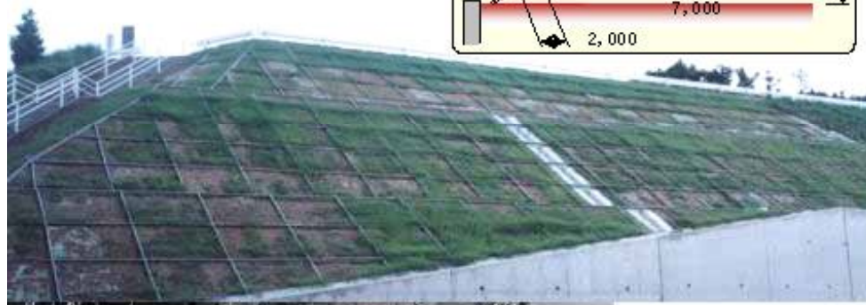
ジオテキスタイルによる補強盛土
