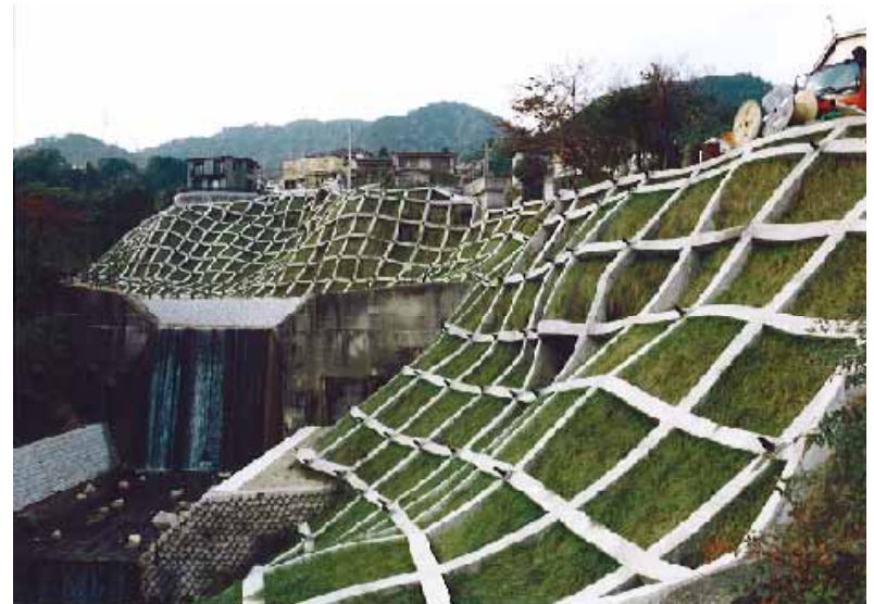
吹付けのり枠工と植生によるのり面保護
