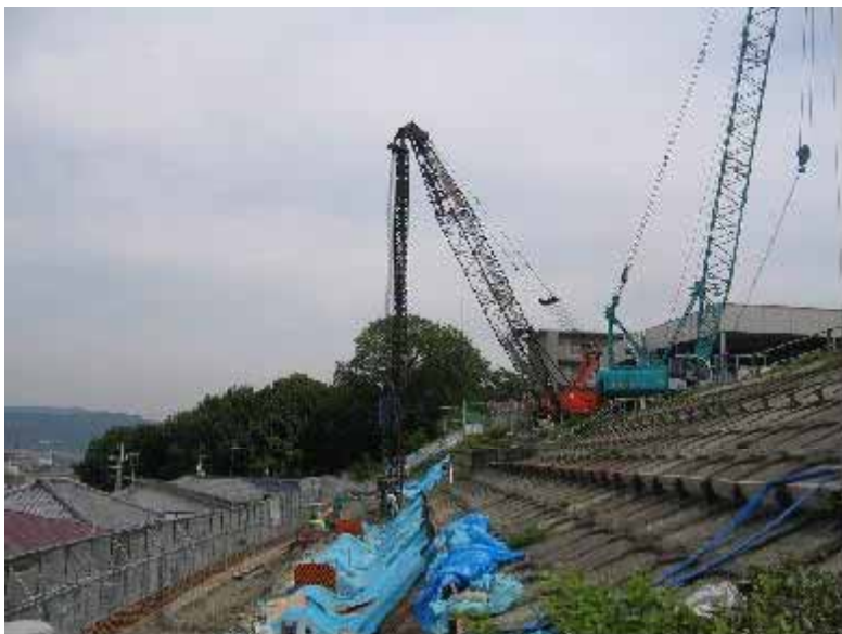
杭の打設状況
