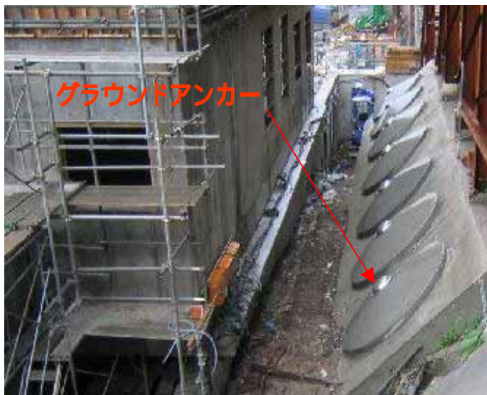
グラウンドアンカーの打設状況
