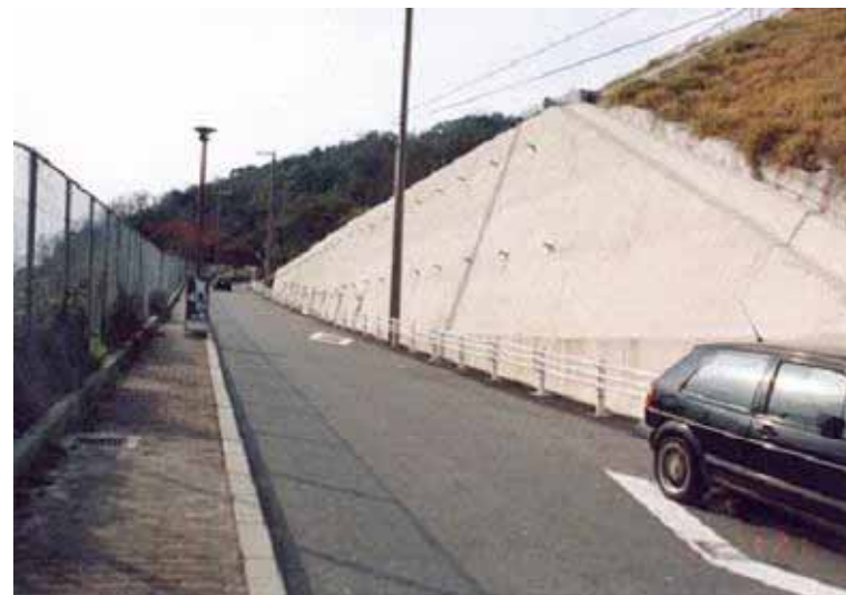
補強後の状況(グラウンドアンカー)
