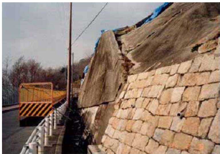
補強前の状況
