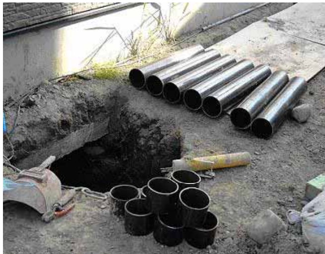
圧入用の鋼管
