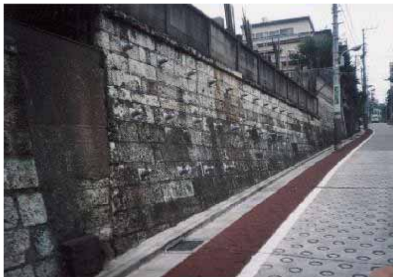
地山補強土工による石積み壁の補強
