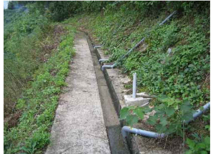
地表面排水工と水抜きボーリング工の流末
