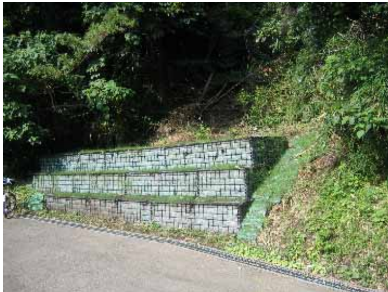
大型の蛇籠による法面保護
