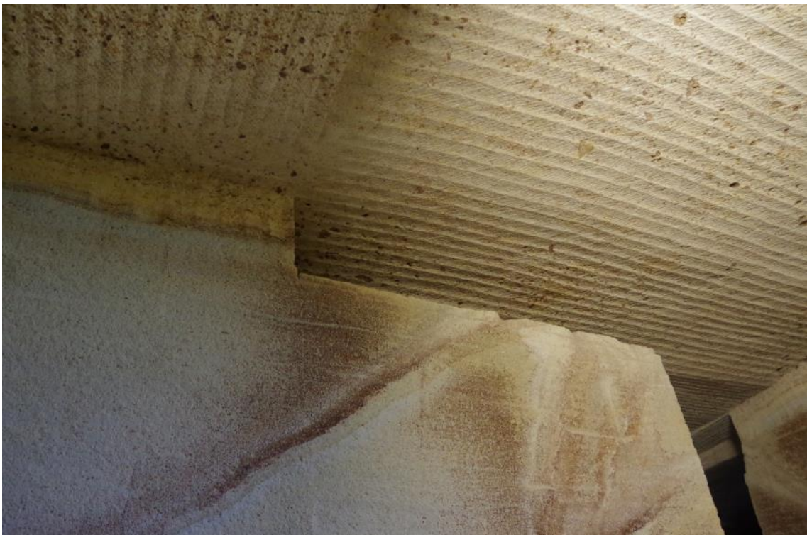
天井も壁も手掘りのつるはしで掘った跡. 上部の空洞は人が入れる程度の大きさ. このような横坑から掘り下げて採石していた.
