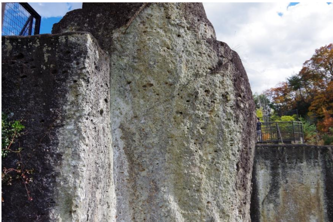
観音様のお顔や足元の劣化は少ないが、展望台高さと同じ位置の胸の位置の劣化や剥離が著しい
