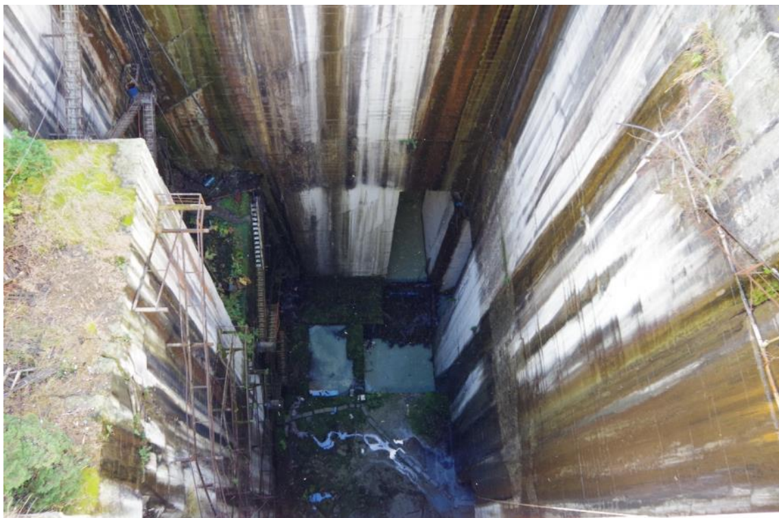
深さ約 70m の立坑，ここから垣根掘りと呼ばれる横坑で採掘している
