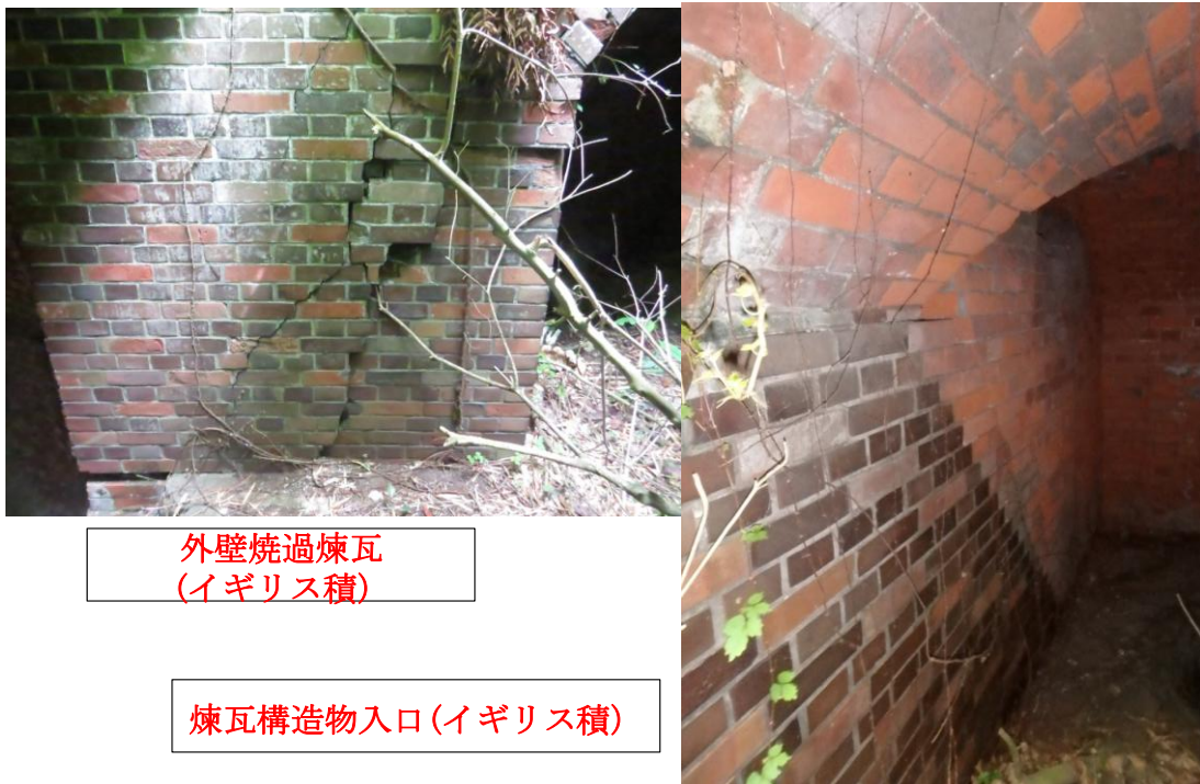
写真-11 第一照明所地下部(煉瓦)
