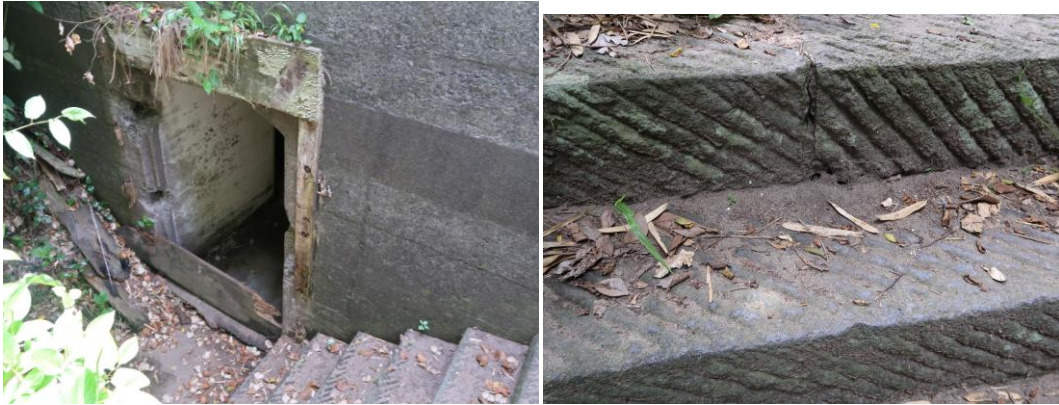
写真-13 コンクリート構造物と上部施設（階段）
