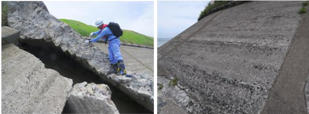
写真-8 コンクリート被覆断面と施工跡
