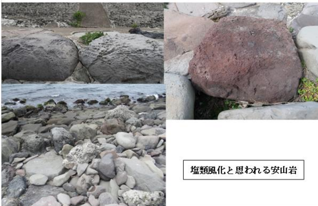
写真-7 護岸石材の風化
