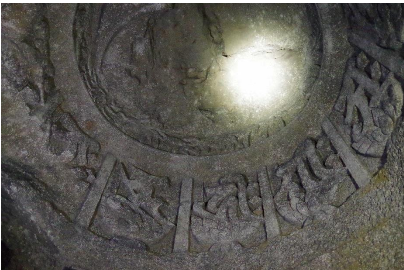
写真 6 金剛界種子曼荼羅. 天井のレリーフは崩落している.
