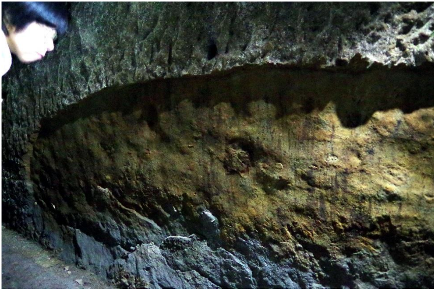
写真 7 壁のはげ落ち. レリーフ部でも一部生じている.
