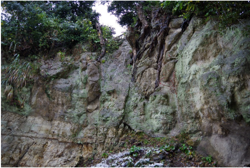
写真4： 木根が岩盤の割れ目に入り込んでいる生物風化の例。充填と擬岩処理を行い、岩盤の表面には強化・撥水処理が行われている。
