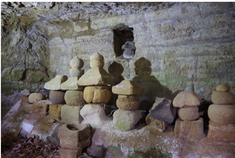
写真7： やぐら内部には五輪塔が供養塔として設置されている。この下に納骨されていると考えられる。やぐら内部では塩類の析出が激しく、やぐらや五輪塔の浸食要因の一つとして問題になっている。
