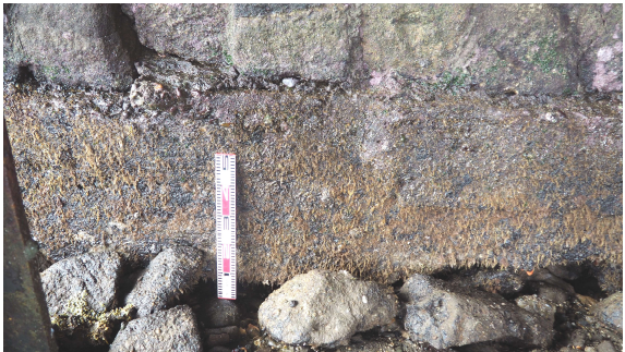
図 9 西側：仮設構台の下 石積擁壁の基礎コンクリート 撮影：2019.8.15
