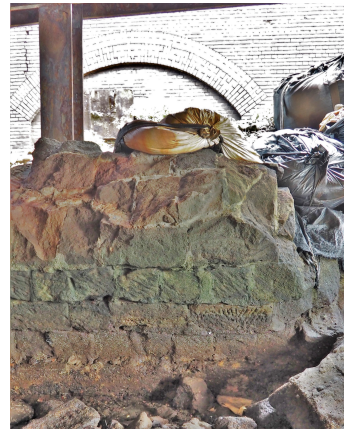
図 11 西側：仮設構台の下。石積擁壁と背後の掩蔽壕の関係 撮影：2019.8.15
