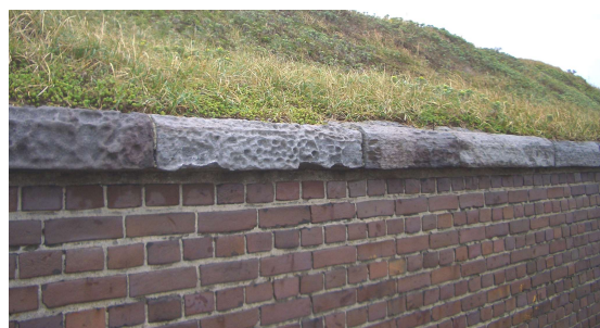
図 33 西側：煉瓦壁の上の安山岩笠石 塩類風化を受けている 撮影：2014.10.20
