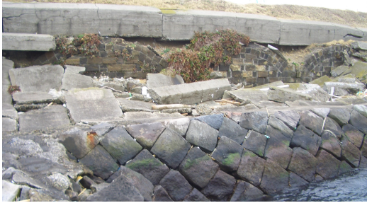
図 20 東側：アーチ状擁壁の 3 連部分の露出と上部パラペット 撮影：2014.2.13
