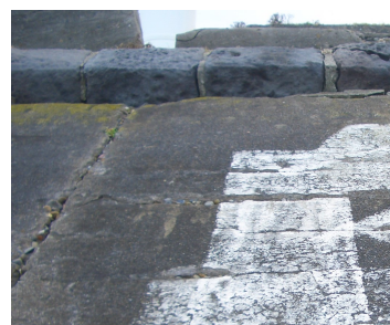
図 31 中央—西側：法面の被覆コンクリート上の安山岩笠石 撮影：2014.11.7
