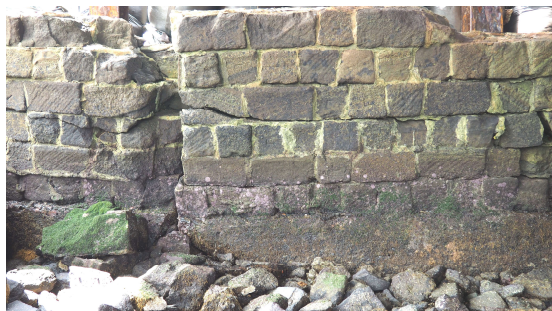
図 16 西側：仮設構台の下 石積擁壁の露出 建設後は盛土に被覆されていた 撮影：2019.8.15
