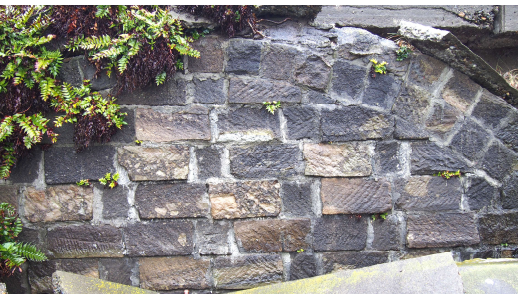
図 22 東側：アーチ状擁壁，変則的フランス積み 撮影： 2015.2.26
