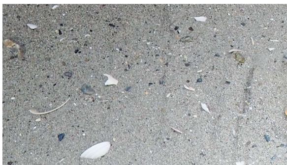
図 27 西側：盛土の海砂の巻出し状況 撮影：2018.9.7
