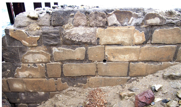
図 17 西側：モルタル被覆の石積擁壁 掩蔽壕側の面 撮影：2015.2.26
