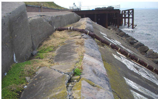
図 36 西側：安山岩の笠石上の犬走と陸側のパラペット 撮影：2014.11.7
