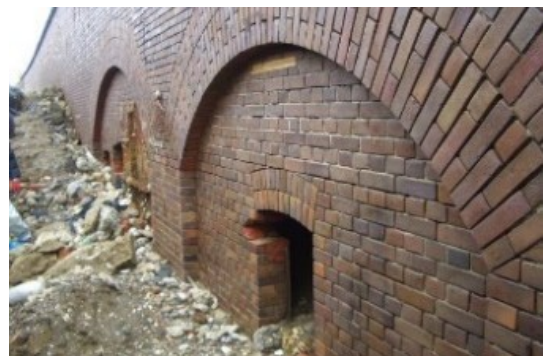
図 13 西側：仮設構台と並行する掩蔽壕 土砂で埋め戻された掩蔽壕 撮影：2014.2.13
