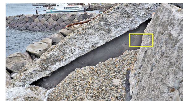
図 26 西側：被覆コンクリート下の盛土の海砂 撮影：2018.9.7
