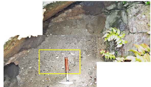
図 24 東側：盛土の海砂と背面の擁壁（右）との接触状況 撮影：2018.9.7
