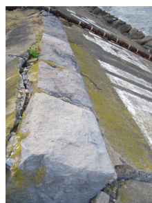
図 31 中央—西側：法面の被覆コンクリート上の安山岩笠石 撮影：2014.11.7
