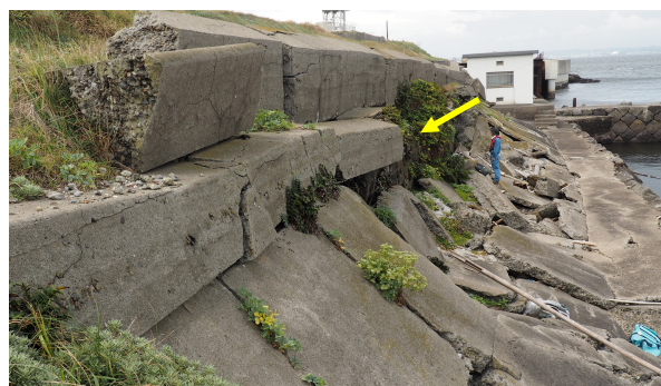
図 30 東側：コンクリート笠石（矢印）と上部のパラペット 撮影：2018.9.7
