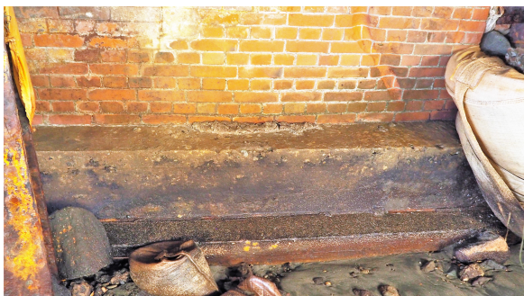
図 10 西側：仮設構台の下。擁壁の延長上の煉瓦擁壁。基礎コンクリート上に載る。撮影：2019.8.15
