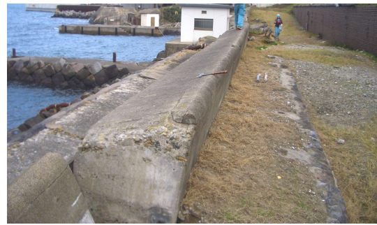
図 37 中央—西側：パラペットを石積擁壁（頂部を草が被覆）の海側に配置 撮影：2014.11.7
