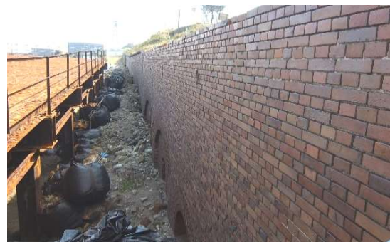
図 12 西側：仮設構台の下石積擁壁（塁道側）と掩蔽壕の煉瓦壁。その間の塁道は土砂を埋め戻し。撮影：2014.10.20
