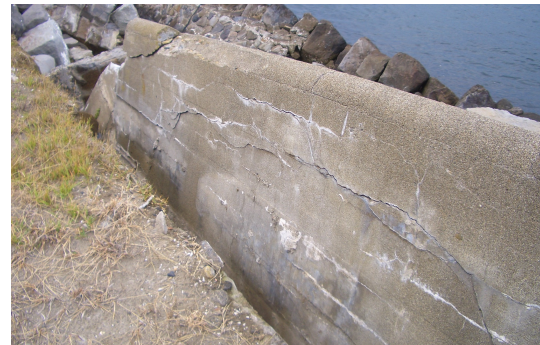
図 38 西側：パラペットの陸側面 撮影：2014.11.7
