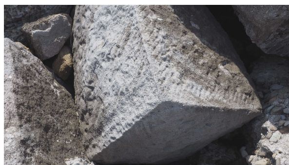
図 32 西側：崩壊した被覆法面の頂上より落下した安山岩笠石 撮影：2019.8.15
