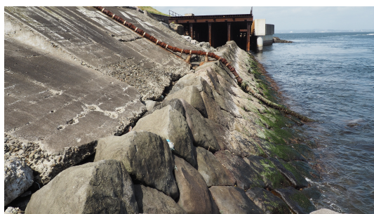
図 2 中央―西側：間知石護岸と法面被覆コンクリート 撮影：2019.8.15
