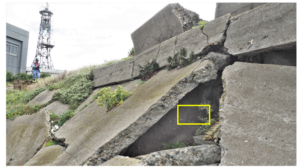
図 23 東側：被覆コンクリート下の盛土の海砂 撮影：2018.9.7
