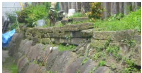
写真4 裏側小土手（西取渡道）天端処理
