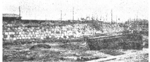
写真1 神奈川台場の石積(裏側標準部)
