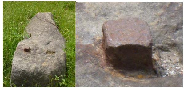
写真5 石積の接合（鉄ダボ）
