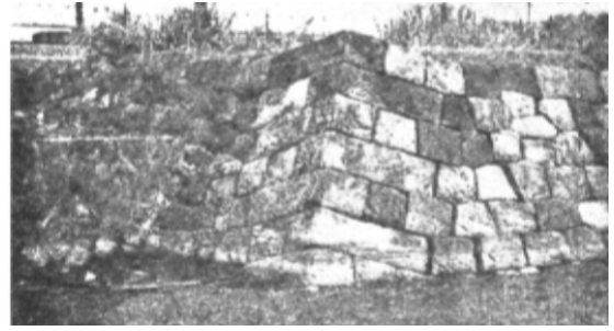
写真4 神奈川台場の護岸隅角（算木積み）
