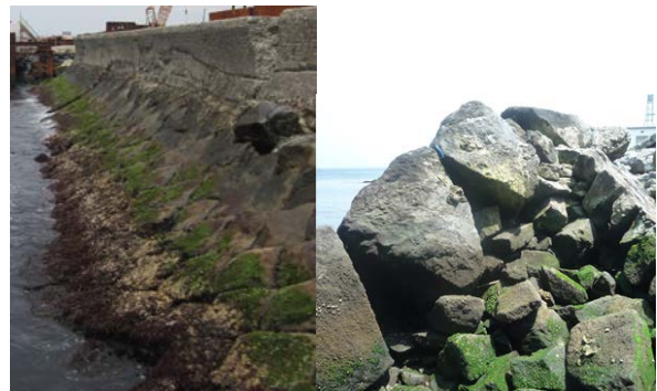
写真3 第二海堡の間知石護岸と裏込
