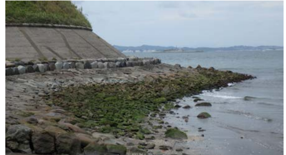
写真2 第一海堡の傾斜護岸
