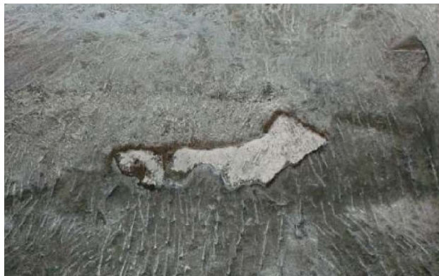
写真7 最深部の壁面に認められる風化塩類
