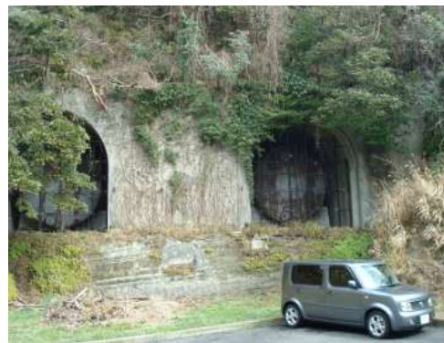
写真1 緑地南側崖面の横坑 (内部に油槽) と露頭 1) (手前露頭: 東西走向, 約10°北傾斜)
