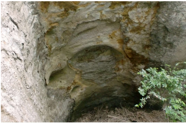
写真4 西側外縁の南側横坑群 1) (風化による天端, 側方崩落跡, 凝灰岩に軽石, 砂岩に貝殻混入)
