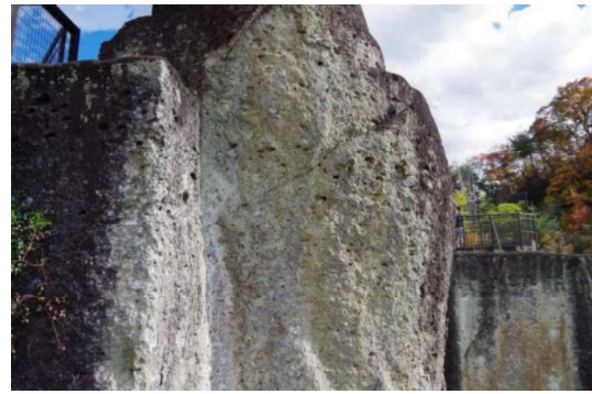
写真-7 平和観音の側面（劣化や剥離が著しい）
