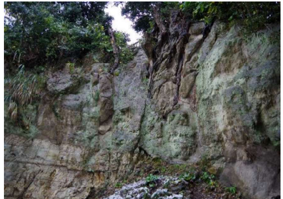
写真-4 木根が岩盤の割れ目に入り込む生物風化
