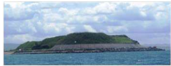
写真-9 第一海堡（右翼方面） 東京湾湾口航路事務所 2019.5.24 撮影
