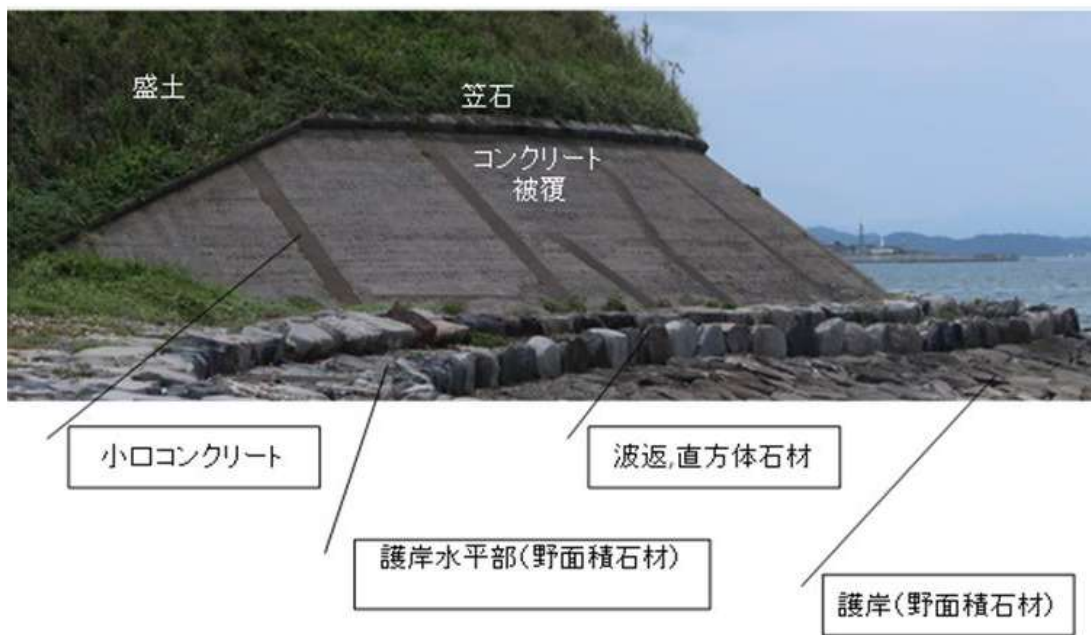
写真-12 右翼北西部護岸
