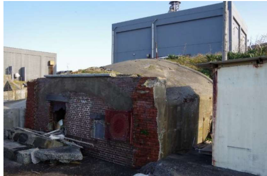
写真-2 北側係船場背後の倉庫
